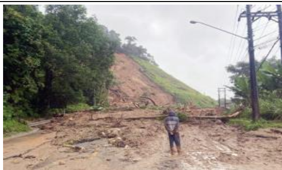
Deslizamento de terra entre Camburi e Boiçucanga, SP.
